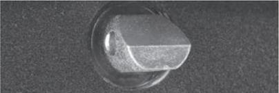
Предохранительные болты петель для T, T1 и при использовании скрытых петель для T2 или T3.                                                                                                                                 | 0   | 0  | 0  | 0  |
